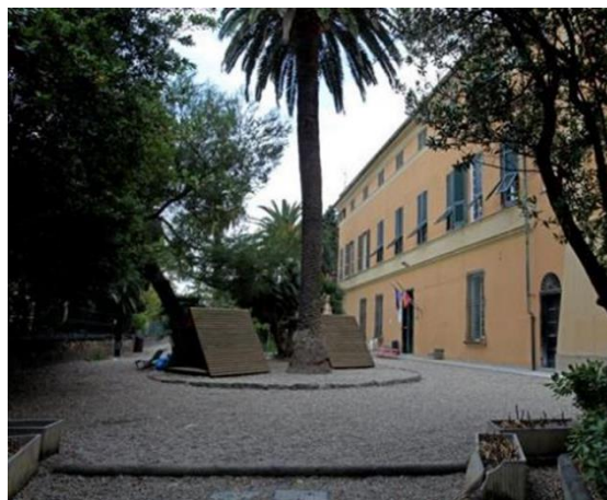
Figura 1.1 - Vista della facciata Sud-Est
