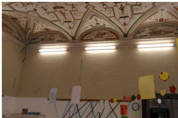
Figura 4.15 - Particolare dei corpi illuminanti ubicati nelle aule
