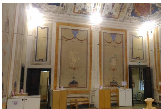
Figura 4.14 - Particolare corpi illuminanti aule
