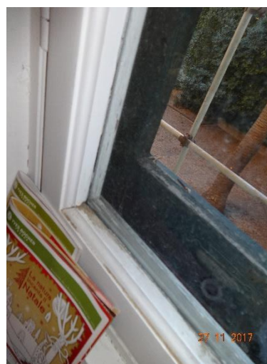
Figura 8.1 – Particolare dei serramenti esistenti
