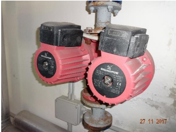
Figura 4.6 - Particolare della pompa di circolazione
