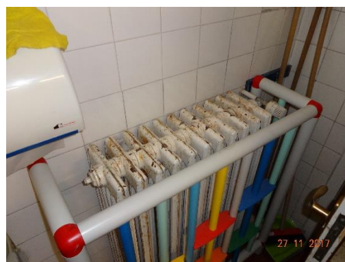
Figura 4.5 - Particolare installazione radiatori
